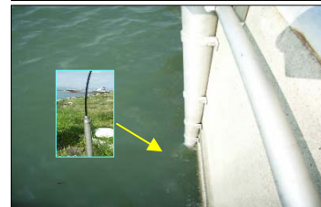
水位計設置事例
