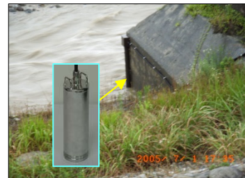
水位計設置事例
